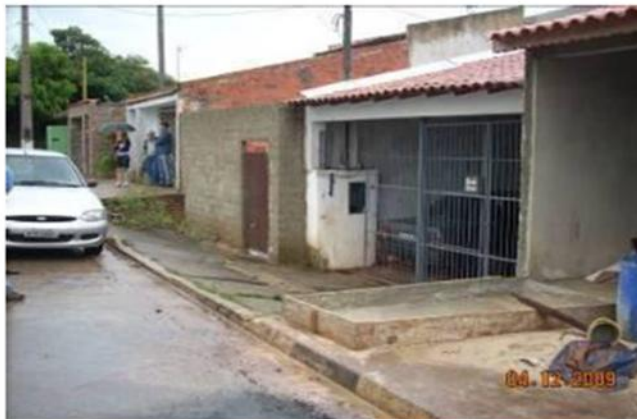
Foto 13: Alagamento de residências na Rua Ind. Camilo Vanni, Jardim Palmira, vista frontal da residência.
