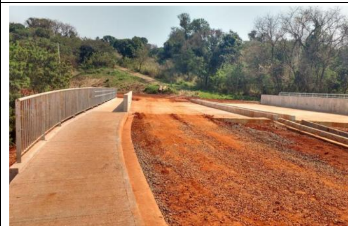
Foto 79: Ponte em concreto armado recém-implantada sobre o Córrego Manduca e obras de reconfiguração do greide da via - Rua Profa. Maria Aparecida Santi - Travessia 16. Coordenadas Geográficas: UTM 7.415.894 S; 208.897 E.
