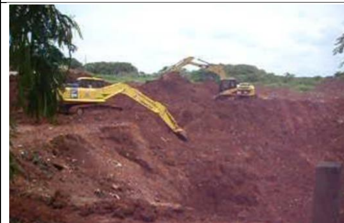
Foto 19: Bairro Boqueirão / Curtume: Máquinas trabalhando para a desobstrução da tubulação que causou o alagamento das 06 residências.
