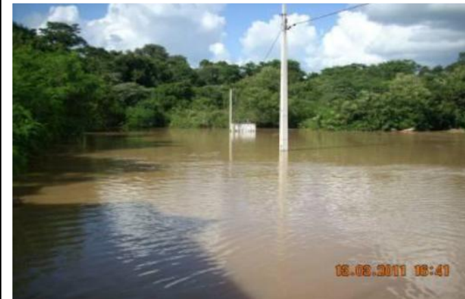
Foto 18: Jardim Tomaz Guedes; Alagamento causado pelo transbordamento do Rio Tatuí.
