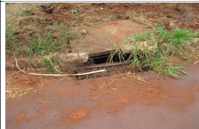
Foto 63: Boca de leão simples existente. Local: Rua José Orsi. Coordenadas Geográficas: UTM 7.417.575 S; 206.893 E.
