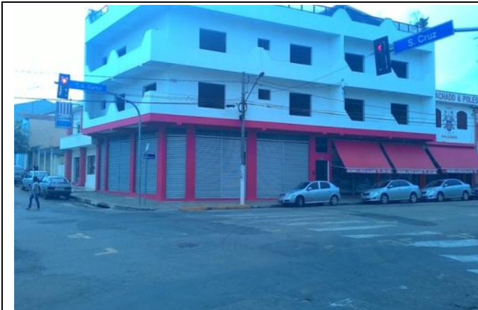
Foto 37: Vista geral do Cruzamento da Rua Santa Cruz e Teófilo Andrade Gama.
