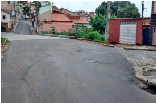
Foto 44: Vista em detalhe da travessia da Rua Tamandaré na travessia do Córrego do Manduca, no cruzamento das vias Otávio de Moraes e São Manuel.
