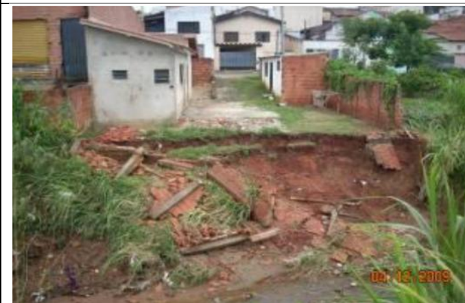
Foto 27: Centro, Rua XI de Agosto, próximo à firma Apllauso Veículos: Imensa cratera, gerada pelas fortes enxurradas e deficiência de drenagem das águas pluviais.
