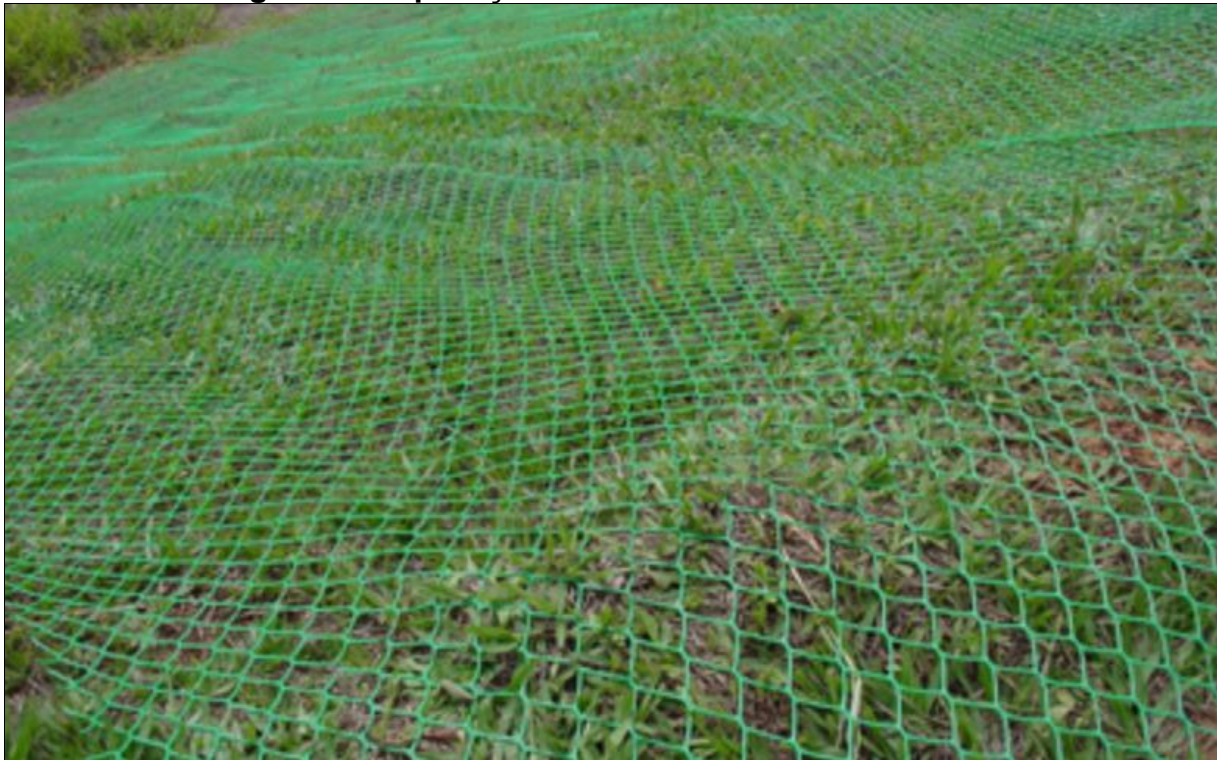
Figura 23 - Aplicação de Grama Armada em Talude.
