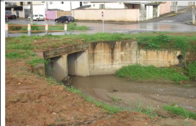
Foto 42: Vista em detalhe da travessia da Rua Tamandaré na travessia do Córrego do Manduca.
