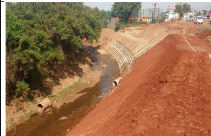
Foto 78: Obras de contenção de margem do Córrego Manduca - Rua Profa. Maria Aparecida Santi. Detalhe da chegada de rede de microdrenagem. Trecho de montante da Travessia 16. Coordenadas Geográficas: UTM 7.415.921 S; 208.732 E.
