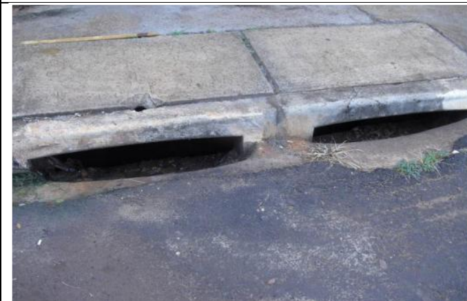
Foto 61: Boca de lobo dupla existente. Local: Rua Isabel Lobo Martins. Coordenadas Geográficas: UTM 7.420.805 S; 212.472 E.
