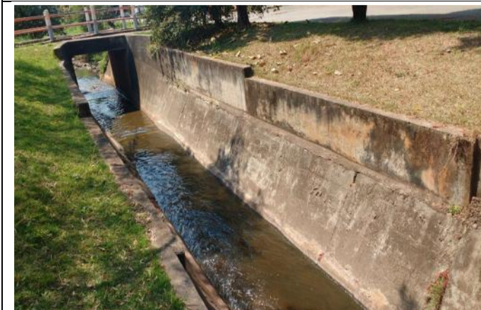
Foto 82: Trecho canalizado (canal aberto em concreto armado) à montante da bacia do Córrego Manduca, Rua Dr. Olavo Ribeiro de Souza altura do nº200, próximo à Travessia 03. Coordenadas Geográficas: UTM 7.414.633 S; 206.921 E.
