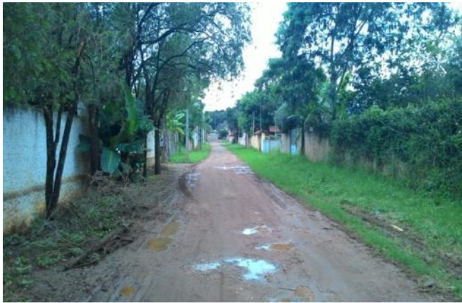
Foto 58: Vista geral da Rua Joaquim Lourenço.
