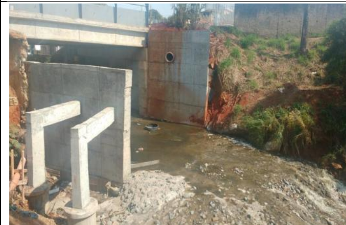
Foto 76: Travessia 15 - Rua Capitão Lisboa recém-implantada. Ponte de concreto armado com muro de ala e enrocamento para dissipação de energia no Córrego Manduca. Coordenadas Geográficas: UTM 7.415.837 S; 208.651 E.
