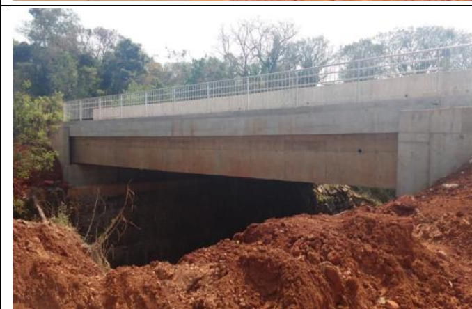
Foto 80: Ponte em concreto armado recém-implantada sobre o Córrego Manduca - Rua Profa. Maria Aparecida Santi - Travessia 16. Coordenadas Geográficas: UTM 7.415.894 S; 208.897 E.
