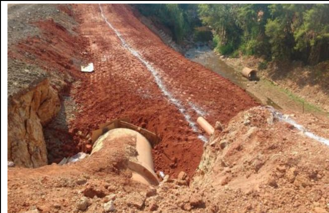
Foto 77: Obras de contenção de margem do Córrego Manduca - Rua Profa. Maria Aparecida Santi. Detalhe da chegada de rede de microdrenagem. Trecho de montante da Travessia 16. Coordenadas Geográficas: UTM 7.415.921 S; 208.732 E.
