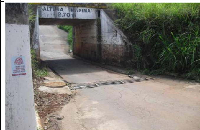
Foto 67: Dispositivo de captação de águas pluviais junto à PV existente. Local: Rua Moreira da Silva. Coordenadas Geográficas: UTM 7.414.121 S; 209.662 E.
