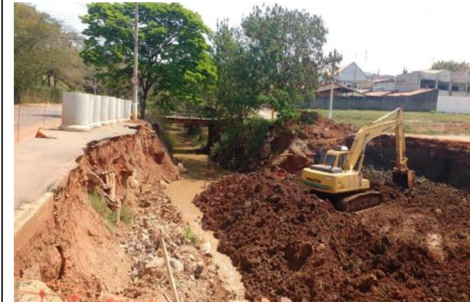
Foto 83: Obras de implantação de ponte de concreto armado sobre o Córrego Manduca na Rua Jornalista Júlio de Mesquita Filho - Travessia 18. Coordenadas Geográficas: UTM 7.415.993 S; 209.930 E.
