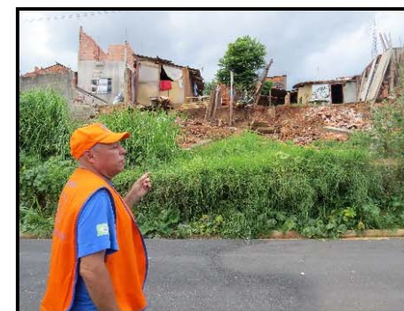
Deslizamento em talude de aterro e de corte da via (Rua João Alfredo Soares) com queda de muro. Notar a casa de madeira próxima à ruptura.
