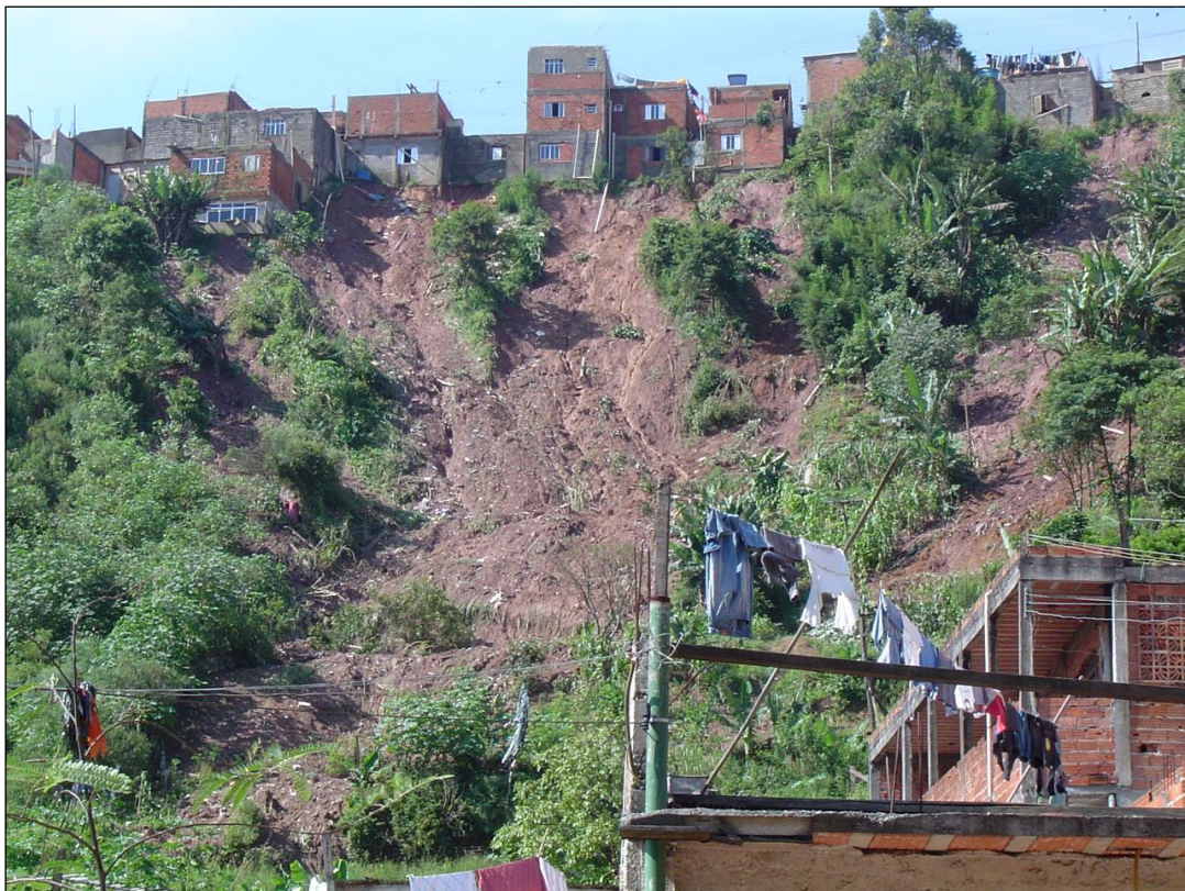
Figura 4 – Deslizamentos planares induzidos pela ocupação (Ministério das Cidades, Instituto de Pesquisas Tecnológicas do Estado de São Paulo – IPT, 2007).
