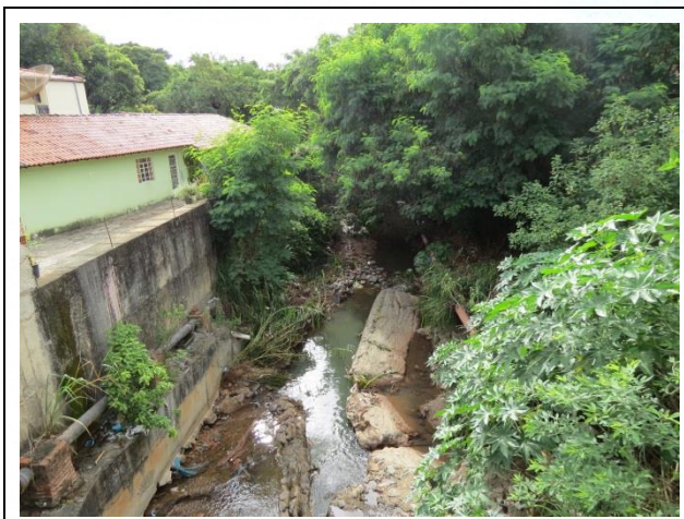
FOTO 15. Vista geral, de montante para jusante, do córrego Ponte Preta. Notar muro na margem esquerda para contenção de solapamento de margem.
