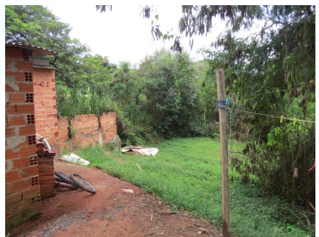
FOTO 36. Vista dos fundos de casa, situada na Rua Michel Nicolau Adum, a qual é afetada pela inundação do afluente do rio Tatuí.
