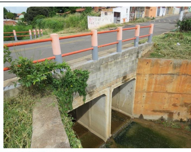
FOTO 32. Detalhe da seção da ponte. Após as obras de ampliação, não foram registradas inundações na Rua São Martinho.
