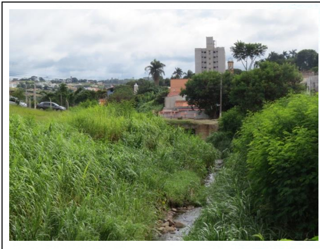
FOTO 35. Vista de um ponto do Ribeirão Manduca, afetada pela inundação. Observar assoreamento por vegetação e entulho.
