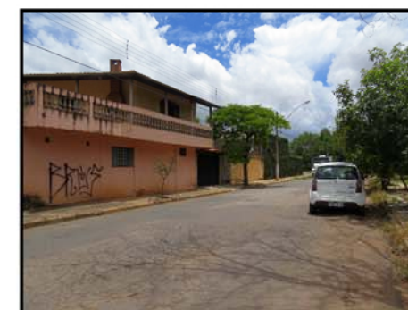
Detalhe de residência afetada pela inundação de 2007 com perdas materiais.
