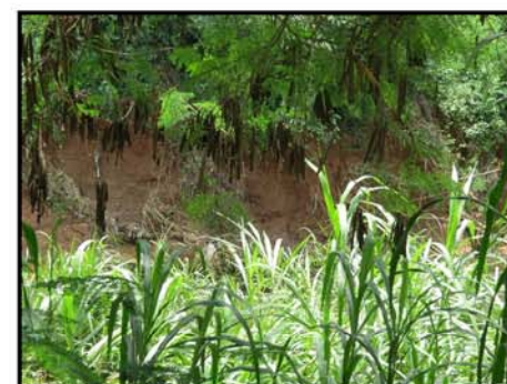
Detalhe da erosão do talude marginal.
