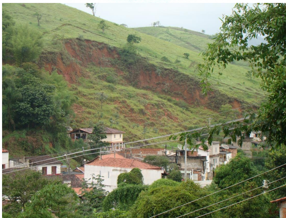
Figura 6 – Deslizamento circular ou rotacional (Fonte: Sirden-CTGeo-IPT).
