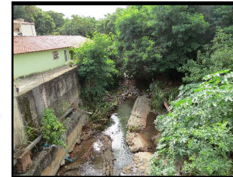
Vista geral, de montante para jusante, do córrego Ponte Preta. Notar muro na margem esquerda para contenção de solapamento de margem.
