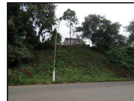
Vista do talude de corte. Notar dimensões (inclinação e altura) e a residência no topo do talude de corte.
