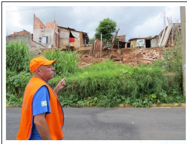
FOTO 1. Deslizamento em talude de aterro e de corte da via (Rua João Alfredo Soares) com queda de muro. Notar a casa de madeira próxima à ruptura.
