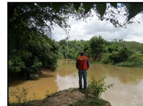
Vista do encontro do rio Tatuí com o rio Sorocaba. Segundo relatos, há formação de um barramento hidráulico que potencializa as inundações no bairro.
