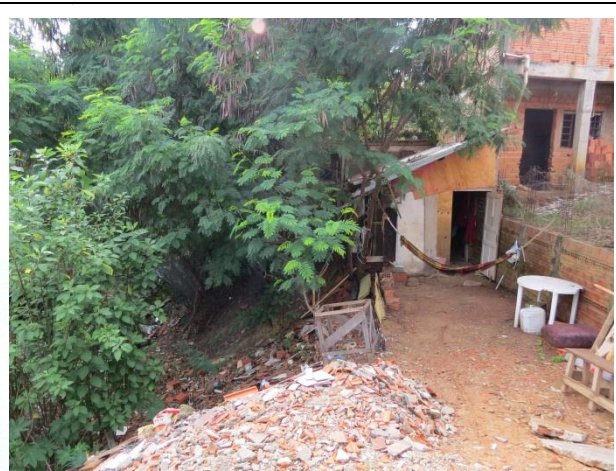
FOTO 14. Vista de moradia instalada na margem direita do córrego Ponte Preta. Notar depósito de entulho no talude marginal.
