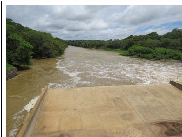
FOTO 21. Vista geral de trecho do Rio Sorocaba, a jusante da barragem.
