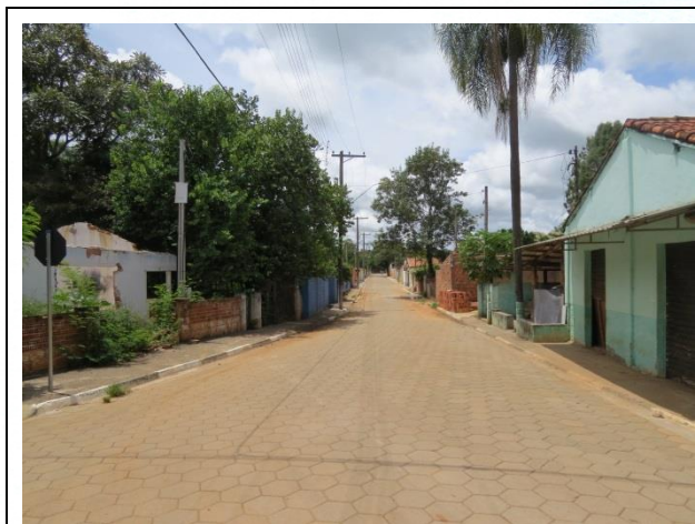
FOTO 23. Vista geral de via de acesso e moradias afetadas pela inundação do rio Tatuí, Rua Laurindo Marques.
