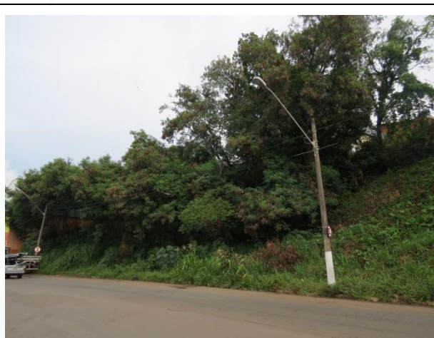
FOTO 6. Vista geral do talude de corte. Notar dimensões (inclinação e altura).
