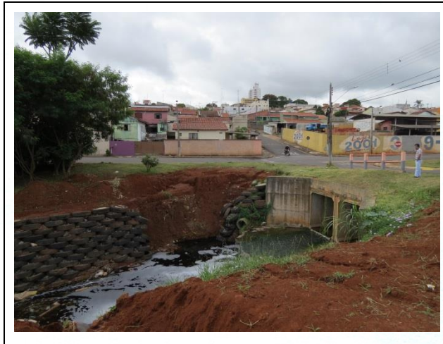
FOTO 29. Vista geral de trecho afetado por inundações. Notar o rompimento da obra de contenção do talude marginal, em função da chuva do dia 26/01/15.
