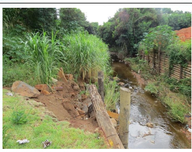
FOTO 12. Registro de movimentações de solo, pontuais, na obra de contenção do talude. Notar o assoreamento na calha do Rio Manduca.
