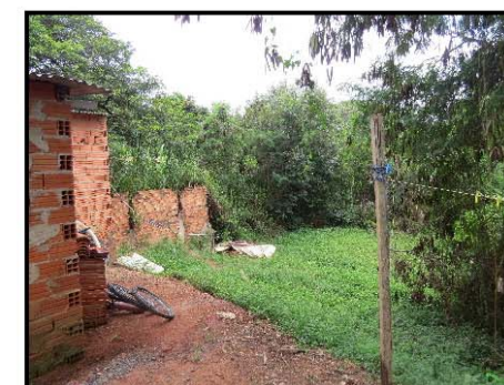
Vista dos fundos de casa, situada na Rua Michel Nicolau Adum, a qual é afetada pela inundação do afluente do rio Tatuí.
