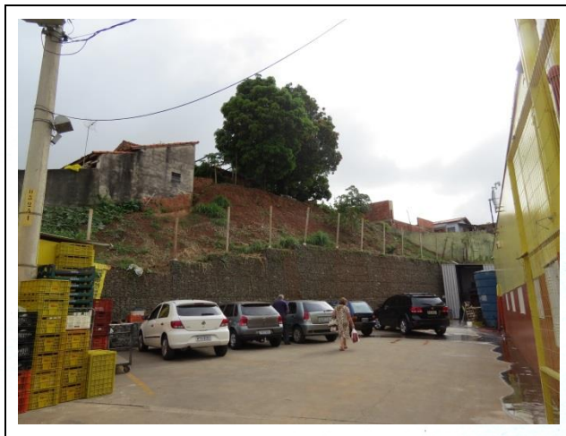
FOTO 9. Muro de gabião, construído atrás de supermercado, para contenção do talude de corte.
