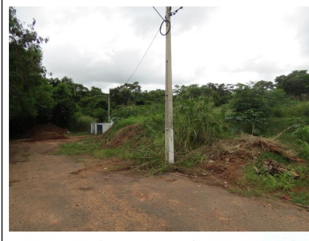
FOTO 33. Vista da estação elevatória da Sabesp afetada pela inundação.
