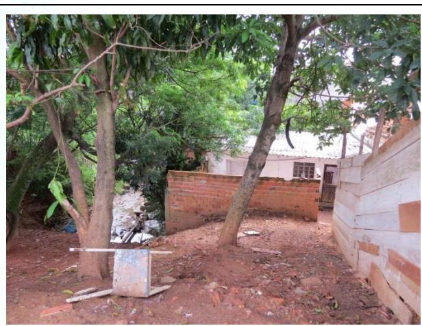
FOTO 16. Vista de moradias localizadas na margem direita do córrego Ponte Preta. Nesse trecho, ocorrem processos erosivos e solapamentos de margem.
