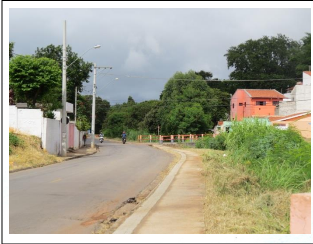
FOTO 33. Vista de um trecho da Rua São Martinho, afetada pela inundação do Ribeirão Manduca.
