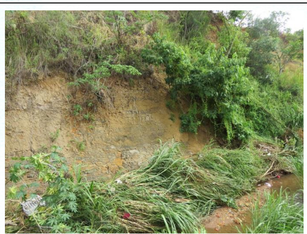
FOTO 20. Registro da altura das águas, em relação à chuva que ocorreu no dia 26/01/2015, evidenciada pelo capim, tombado.
