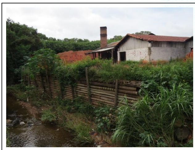
FOTO 11. Vista da margem direita do Rio Manduca. Notar o assoreamento na calha.
