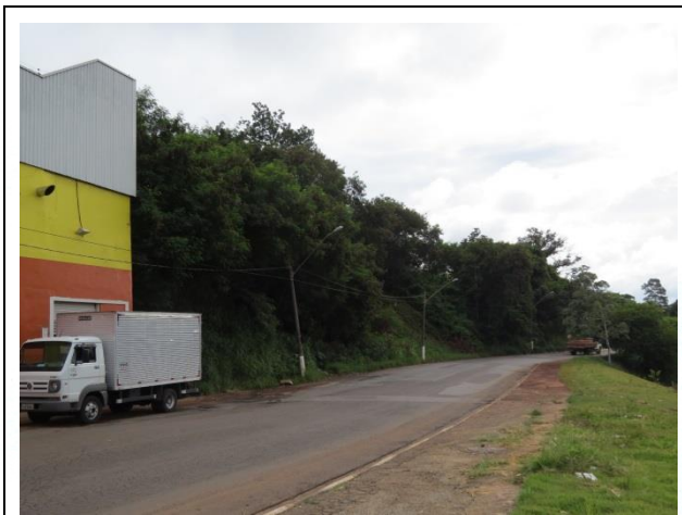
FOTO 5. Vista geral da área. Há inclinação dos taludes e proteção vegetal nesse trecho.
