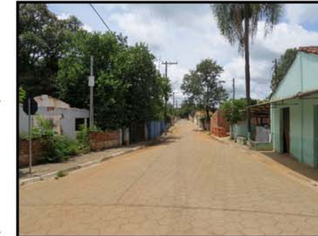
Vista da R. Laurindo Marques e moradias afetadas pela inundação do rio Tatuí.
