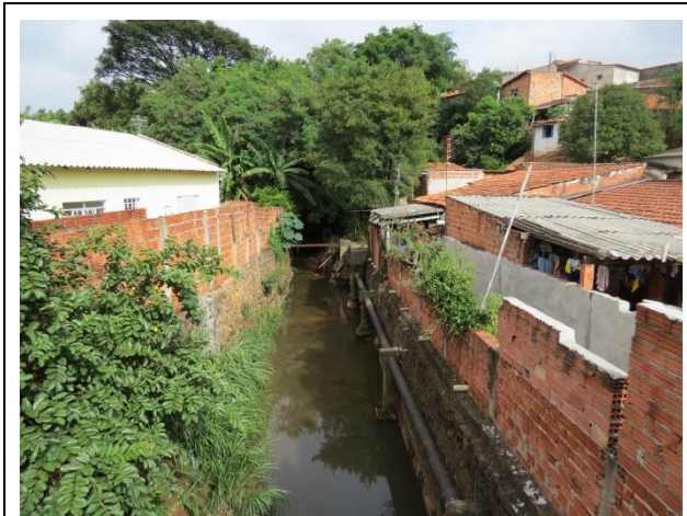
FOTO 13. Vista geral das moradias afetadas pela inundação do córrego Ponte Preta. Notar as tubulações de lançamento de água servida e as dimensões do canal.
